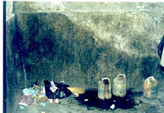
Servicio sanitario en las celdas policiales
